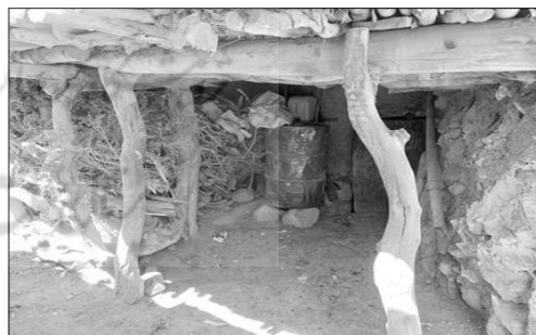
ت ۱۲. استفاده از ستون‌های چوبی به منظور حمل بار حاصل از تیرهای ایوان
