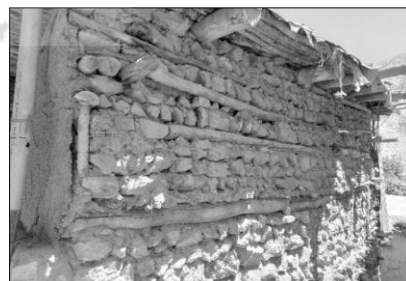
ت ۹. استفاده از الوارهای چوبی در دیوار به منظور مستحکم نمودن
