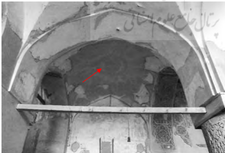
تصویر ۲۷. نمای داخلی تاق «۲» در تصاویر ۲۵ و ۲۶. اجرای اندوهای گچ در تیزه تاق در عملیات مرمتی مشخص است
