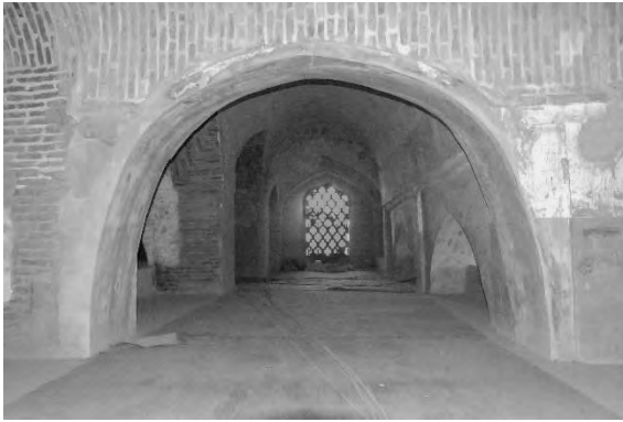
تصویر ۲۳. دهانه مسدود شده تاق زیرین در روی کمربوشها به منظور اجرای تاق آهنگ (مأخذ: مجموعه تصاویر نویافته سال ۱۳۴۷، نگارنده)
