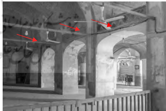
تصویر ۱۶. چگونگی قرارگیری تاقهای کم خیز کمرپوشهای غربی بر روی ستونهای این شبستان (مأخذ: نگارنده)
