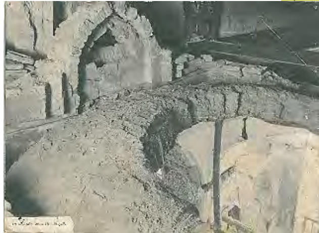
تصویر ۲۲. روی سطح تراز کمربوش غربی، تاق آهنگ اجرا شده روی تاقهای زیرین به منظور افزایش ارتفاع روی کمربوشها (مأخذ: نگارنده)
