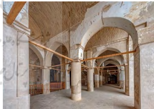
تصویر ۱۳. تاق آهنگ اجرا شده بر روی ردیف تویزه های شبستان قبلی (مأخذ: نگارنده)
