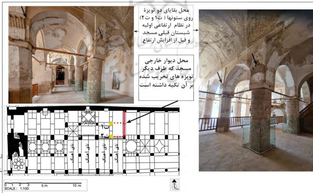
تصویر ۲۴. موقعیت بقایای تویزه‌های باقیمانده بر روی دو ستون شبستان قبلی نقشه پایه مرکز اسناد میراث فرهنگی اصفهان، تصرفات از نگارنده
