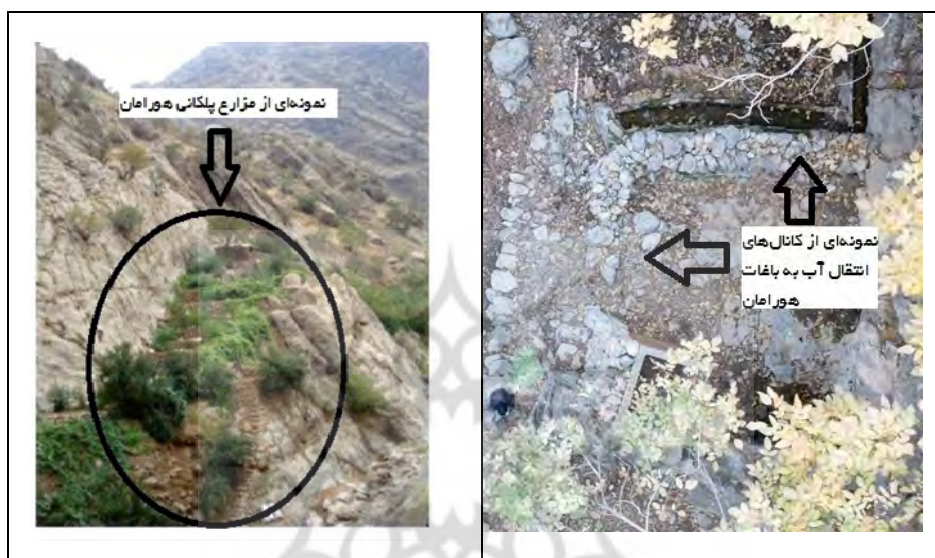
عکس ۸- جزئیات کانال آب‌ها و تراس‌بندی زمین‌های صخره‌ای برای انتقال آب و احداث باغ هورامان (نگارندگان).
