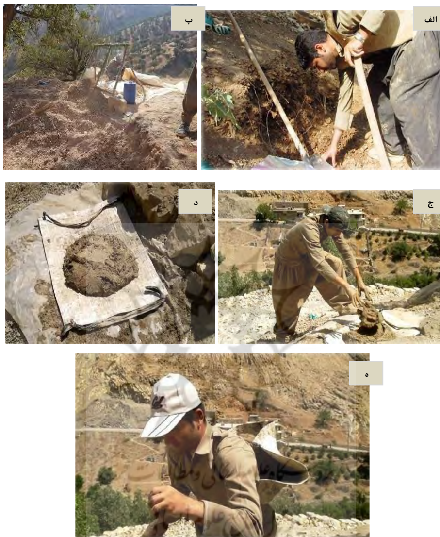
عکس ۵ - کندن خاک مناسب برای تهیه کاسه بندی (الف)، الک کردن خاک (ب)، تهیه گل و ورز دادن به وسیله شاگرد سقز چین (ج)، قورکیش (د)، انتقال گل آماده به وسیله شاگرد سقز چین به محل کاسه بندی (ه) (عکس از فریبرز عزیزی، تابستان ۱۳۹۶)
