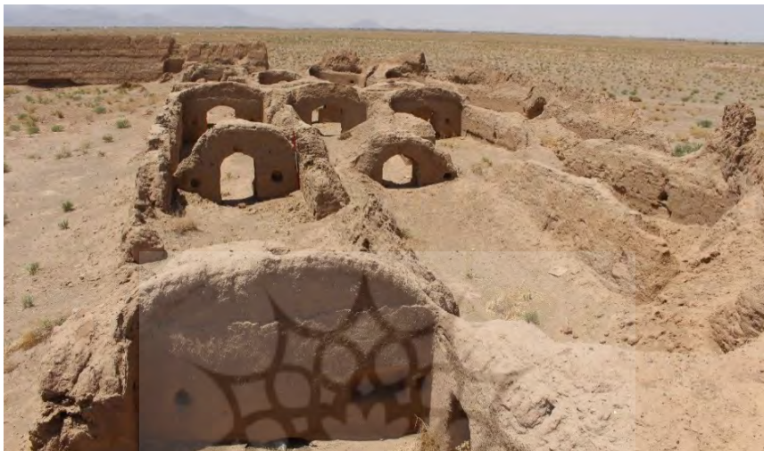
عکس ۱۷- مجموعه ساختمانی در قسمت غربی مجموعه آسیاب دید از شمال (نگارندگان، ۱۳۹۷)
