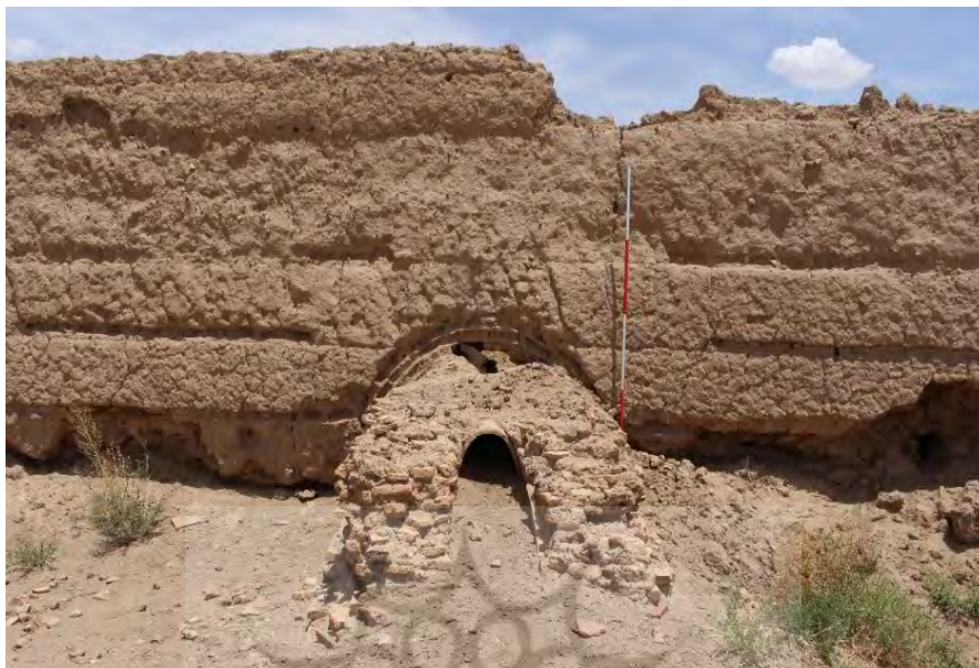
عکس ۷- کانال ورود آب به داخل آسیاب از زیر دیوار دفاعی در قسمت شمال مجموعه آسیاب (نگارندگان: ۱۳۹۷)
