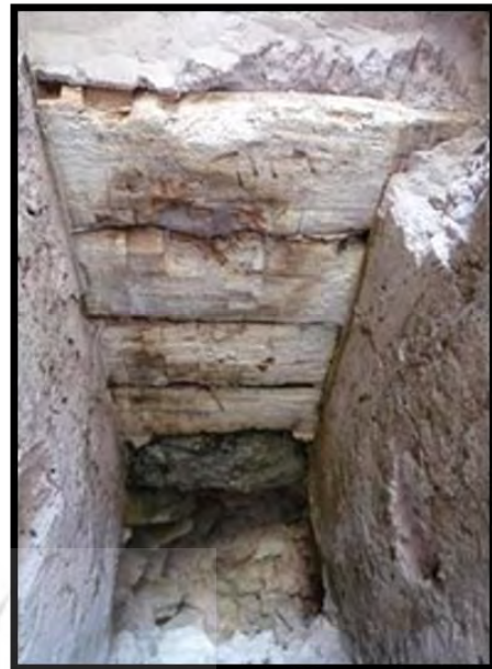
شکل ۱۵. تیرهای چوبی ضخیم سقف (Dan et al., 2018)
