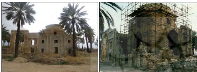
شکل ۱. الف) نمای جنوبی و جنوب غربی بقعه شیخ خلیفه خفر قبل از مرمت (آرشيو اداره کل ميراث فرهنگي استان فارس) ب) نمایی از بقعه شیخ خلیفه بعد از مرمت (Authors, 2022)
