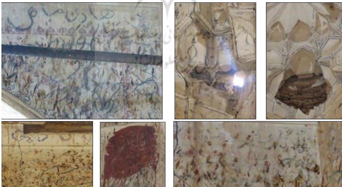
شکل ۱۰. نمونه‌ای از آسیب‌های وارده به آرایه‌های درونی بقعه شیخ خلیفه خفر توسط عوامل گوناگون (Authors, 2022)
