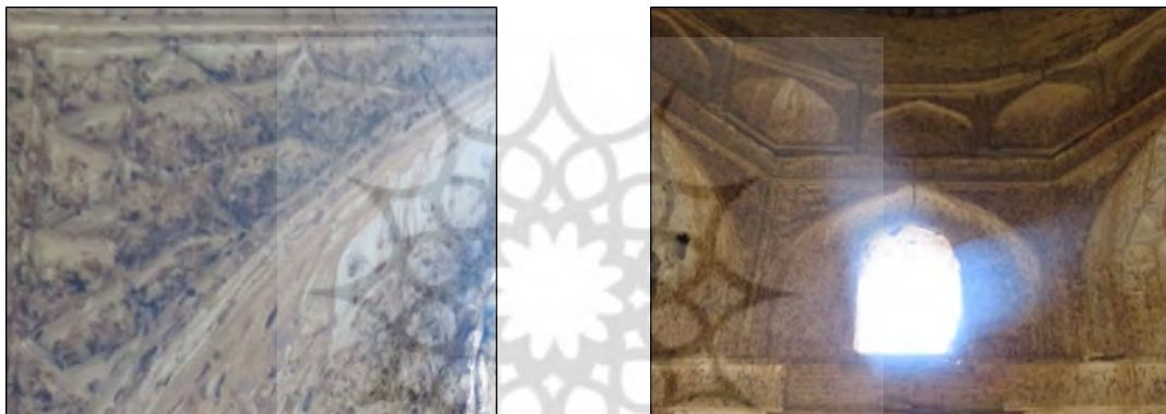
شکل ۹. نمونه‌ای از نورگیرهای بقعه شیخ خلیفه خفر و جزئیاتی از نقوش هندسی (گره پنج) آرایه‌های گچی به‌کاررفته در لچکی آنها (Authors, 2022)
