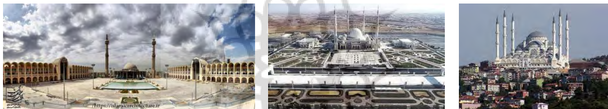
شکل ۷. در بزرگ‌ترین مساجد معاصر کشورهای اسلامی که دارای سنت‌های معماری قدرتمندی هستند، غالباً از طریق ارجاع به سبک‌های تاریخی هر کشور بر هویت ملی تأکید می‌شود. چپ: مصلی امام خمینی تهران، وسط: مسجد الفتح العلیم در مصر، راست: مسجد چاملجا در ترکیه.
