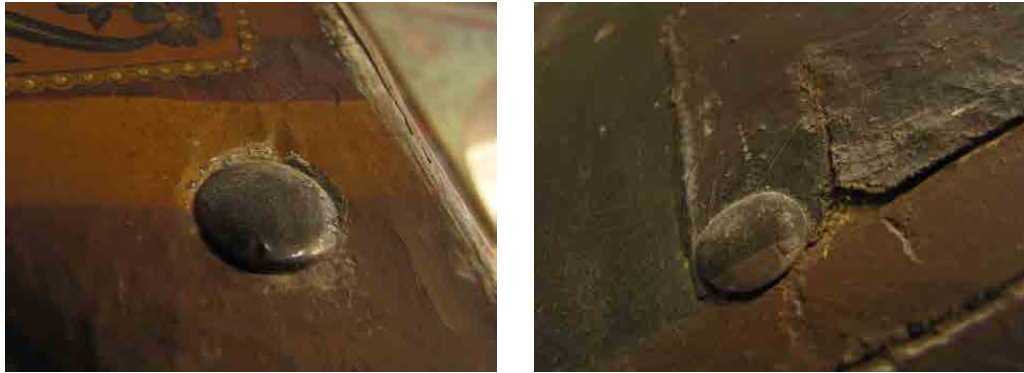
تصویر ۹. میخ‌های کوبیده شده در اطراف دیوارنگاره‌های بوم پارچه جهت افزایش میزان اتصال آن‌ها به دیوار (نگارندگان، ۱۴۰۰).
