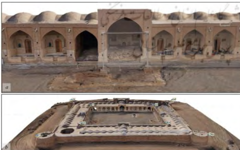
تصویر ۱۳- خروجی مدل سه‌بعدی کاروانسرای دیرگچین با بافت واقعی، a: دید ایوان شرقی از حیاط مرکزی دیرگچین، b: دید پرنده از ضلع شمالی مدل سه‌بعدی اثر.
