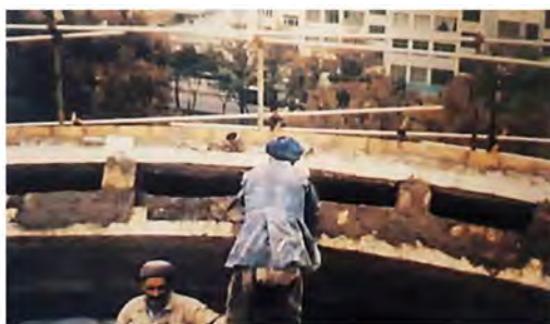
تصویر ۱۱- سمت راست: پلان از محل چنبره گنبدخانه؛ سمت چپ: ساخت دوپوسته گنبد مسجد دانشگاه شریف به صورت هم‌زمان به صورت صندوقه. مأخذ: (زمرشیدی، ۱۳۸۹، ۳۴۳)
