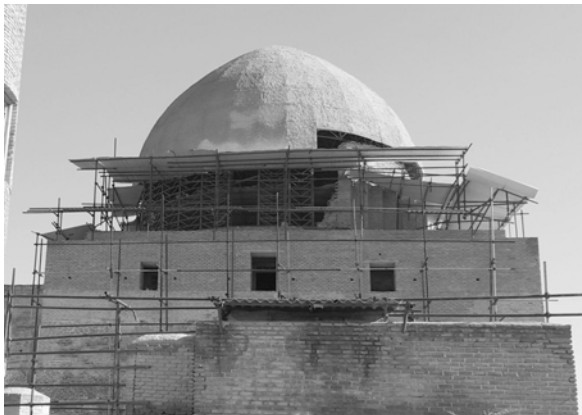
تصویر ۴- گنبد جدید جمعه مسجد با سازه فلزی و روکش شاتکریت سیمانی.
