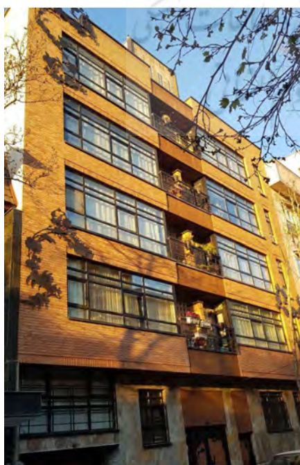
تصویر ۱- نمای کلی ساختمان (دید شمال شرقی).
