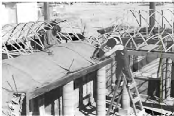
تصویر ۳- پروژه‌ی مکزیکالی: اجرای سقف با استفاده از روش‌های بومی. ماخذ: (Alexander, 2005, 554)
