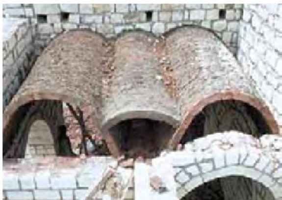
تصویر ۶- پروژه‌ی گورنای جدید؛ ساخت با استفاده از مصالح بومی و فناوری بومی. ماخذ: (Serageldin, 2007, 46)
