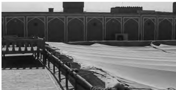
تصویر ۷- جزئیات اتصال پوشش چادری هتل ملک‌التجار یزد. (مأخذ: برداشت شده توسط مهندس امیر عباس یآوری، ۱۳۹۲)
