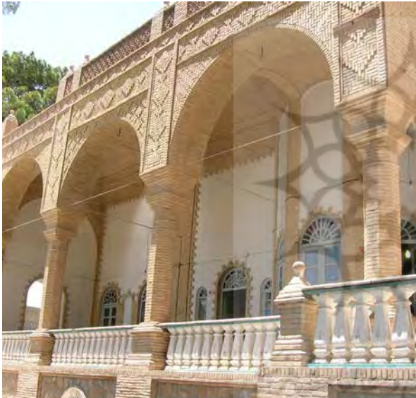
تصویر ۲۷- ساختمان فرمانداری، ایوان و نمای اصلی حیاط، کرمان، ۱۳۰۲ ش.
