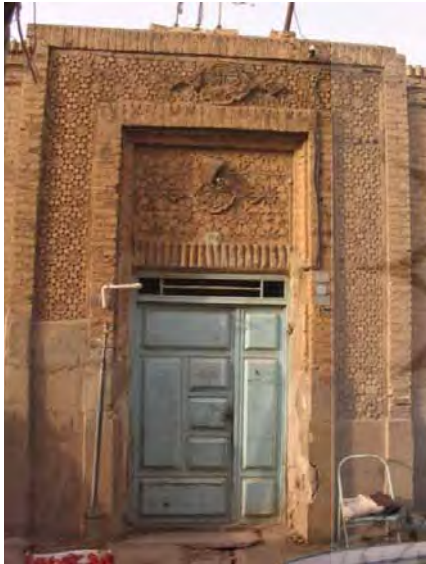
تصویر ۱۰- کارخانه برق، کرمان، ۱۳۱۰ ش.
