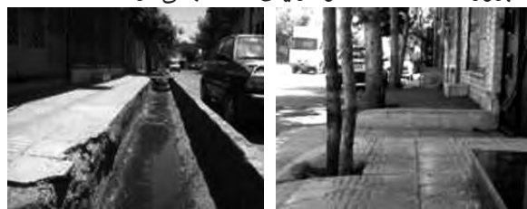
تصویر ۲- بیرون زدگی پله ابنیه در معبر و جداول روباز و خطر آفرین.
