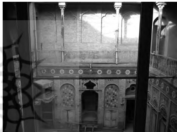
تصویر ۲۳- حیاط برانی خانه ابومشتاق؛ وفور سایه به دلیل بلندی دیوارها و کمی مساحت حیاط.
