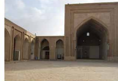
ب- ایوان جنوبی مسجد جامع گناباد
