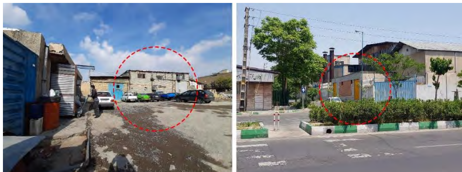
شکل ۲. راست: بنای پست برق به‌عنوان عامل محدودکننده فیزیکی: نمونه‌ای از انعطاف‌پذیری متناسب با شرایط سایت چپ: ابنیه فاقد الگوی طراحی با کیفیت پایین و الحاق شده به کارخانه: نمونه‌ای از انعطاف‌پذیری برای استفاده
