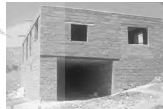
تصویر ۱۱ - استفاده از مصالح جدید نظیر بلوک‌های سیمانی، (مأخذ: نگارندگان)
