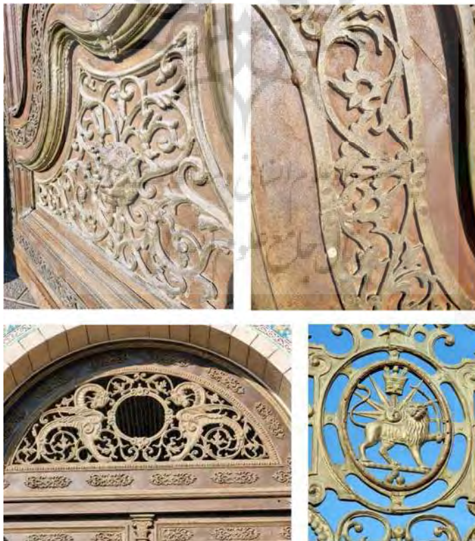
تصویر ۱۲. بخش‌هایی از درهای سردر باغ ملی، به روش ریخته‌گری و میخ و پرچ. (عکس: نگارنده)
