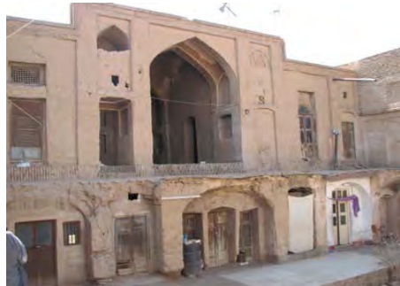
تصویر ۲۱: خانه بهادر با حیاط گودال در محله گازرگاه یزد (مرکز اسناد سازمان میراث فرهنگی استان یزد)
