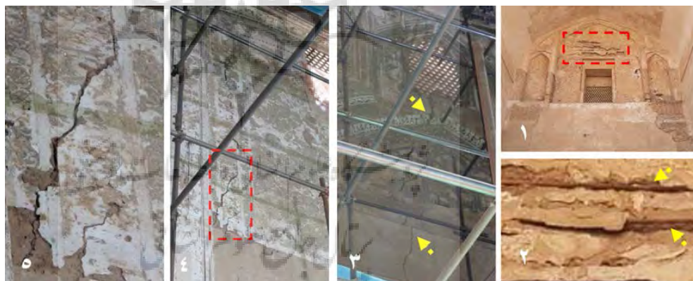
تصویر ۸: ۱. جانمایی محل آثار نمایان میلگردها در کلاف کشی گنبدخانه در سال ۱۳۴۲؛ ۲. بزرگ‌نمایی بخشی از آن در محل میلگردهای دور گنبد؛ ۳ و ۴. نشان‌دهنده ترک‌های ناشی از نشست بنا در پایه‌های گنبدخانه در دیوار شرقی و دیوار جنوبی؛ ۵. بزرگ‌نمایی ترک دیوار جنوبی در تصویر ۴
