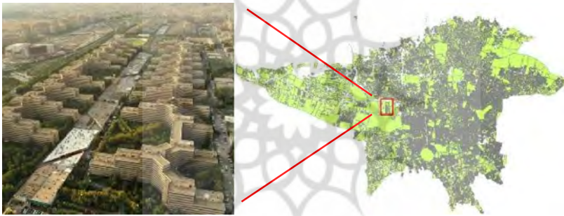
شکل ۶: محدوده جغرافیایی مجتمع مسکونی اکباتان تهران
