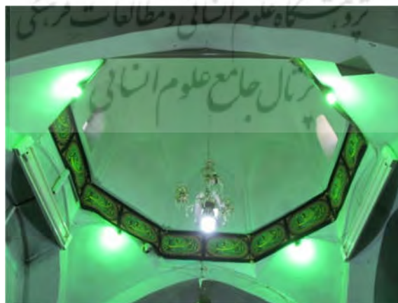
تصویر (۱۸): شیوه گوشه‌سازی در گنبدخانه بقعه به روش کاربردی و طاق‌بندی
