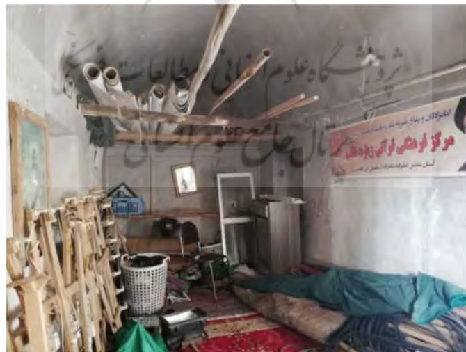
تصویر ۲۰: اتاق جانبی گنبدخانه (شمال)
