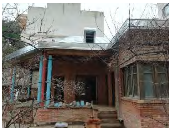
شکل ۷: دید به نمای جنوبی خانه نیما یوشیج Fig. 7: The southern view of Nima Yoshij's house
