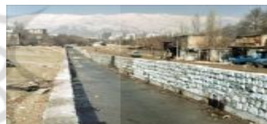
شکل (۲). تصاویر وضع موجود رودره درکه
