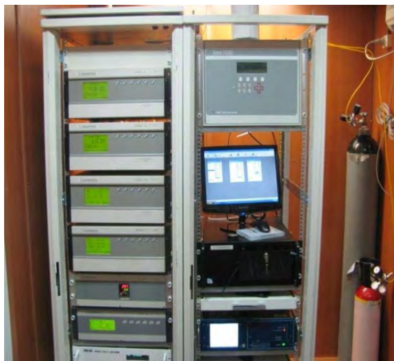
نگاره ۱: نمای بیرونی و درون یک ایستگاه زمینی پایش کیفیت هوا (سپهرنیا، ۱۳۹۴)
