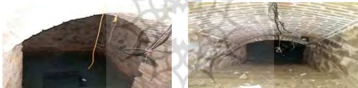
شکل ۳: راه پله و تاق گهواره ای و مخزن و پاشیر آب‌انبار امامزاده احمد سنقر (نگارنده، ۱۳۹۸)
