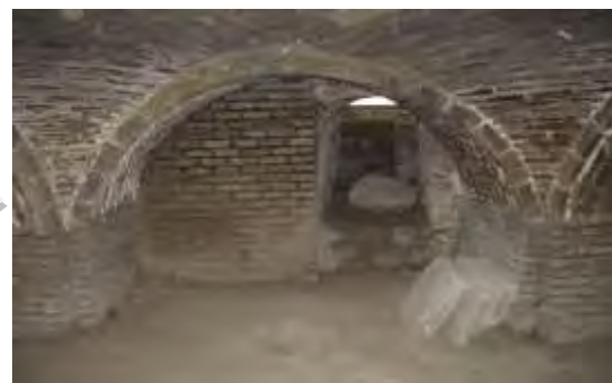
شکل ۴: کرسی بقعه مالک که در زیر بقعه مالک به صورت چهار تاقی آجری ساخته شده است (نگارنده، ۱۳۹۲)
