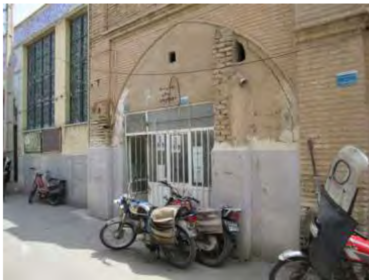
تصویر ۹. در نمونه مسجد خندق فضای ورودی آب انبار مسدود و به مغازه تبدیل شده است.
