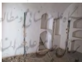
شکل ۱۶- قبل از مرمت اندود دیوار و کف (مأخذ: آرشیو عکس میراث فرهنگی)
