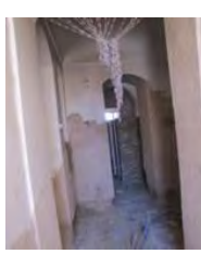
شکل ۱۸- قبل از اجرای فضای سرویس بهداشتی (مأخذ: آرشیو عکس میراث فرهنگی)
