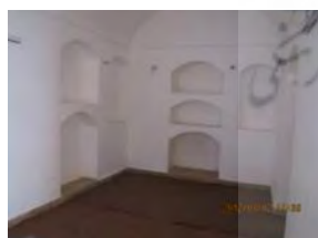
شکل ۱۷- بعد از مرمت اندود دیوار و کف اتاق (مأخذ: نگارنده)
