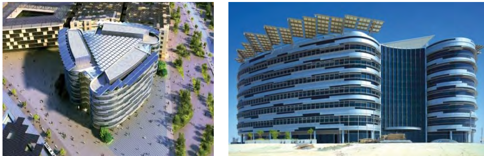
شکل ۱۴- مرکز جهانی IRENA، با بازشوهای متحرک و صفحات فوتوولتایک بر روی بام (Masdar, 2019)
