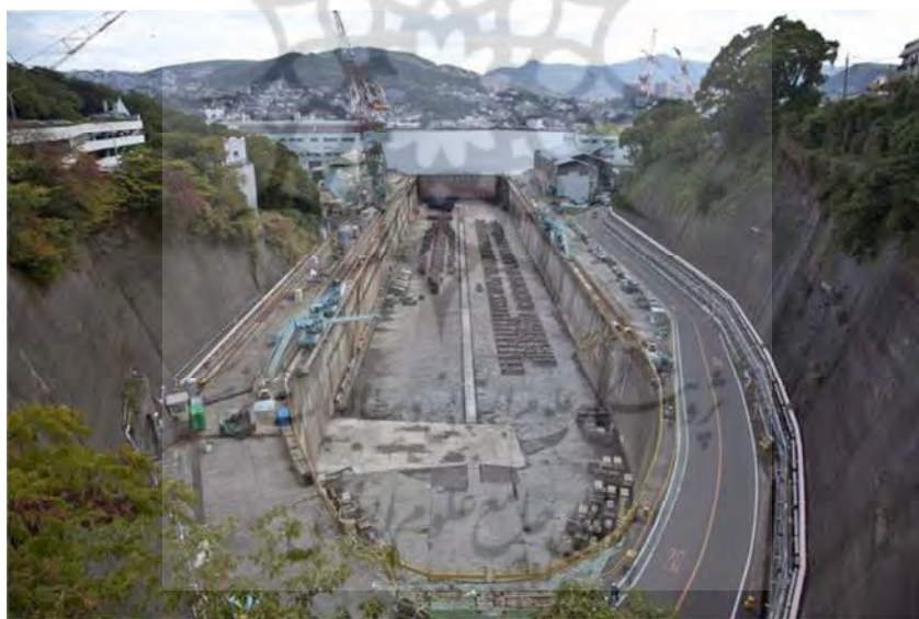
شکل ۳. کارگاه ساخت کشتی میتسوبیشی در ناگاساکی. https://whc.unesco.org/en/list/1484
