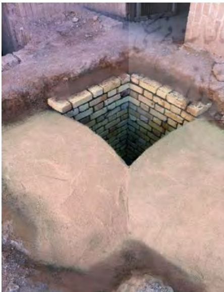
شکل ۱۲. اندود عسلی آهک روی طاق و تعبیه دریچه دسترسی و تهویه هوا منبع: ه. رضوی
