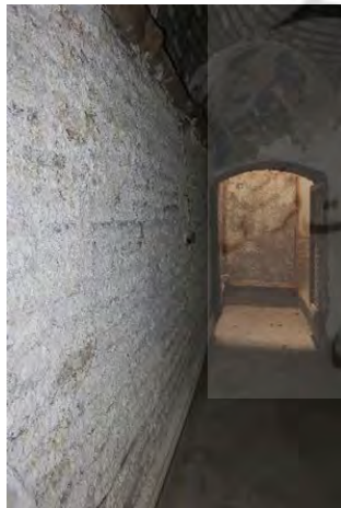
شکل ۸. خانه کلاه‌دوزها، یزد، جداره داخلی یک ناکش که در گذر زمان درست کار کرده است، املاح به‌جامانده روی جداره نشانه این است که چه حجم بالایی از رطوبت از روی سطح این جداره تبخیر شده است. این جداره هم‌اکنون به‌واسطه حجم عمده املاح روی آن کارایی‌اش بسیار کم شده و باید شوره‌زدایی شود یا آجرها تعویض شوند.
