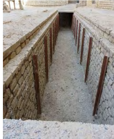
شکل ۳. خانه اخوان سیگاری، یزد، اگر ناکش سقف نداشته باشد، عملکرد مطلوبی را در تبخیر رطوبت خواهد داشت ولی در عمل این کار عموماً نشدنی است. منبع: ه. رضوی
