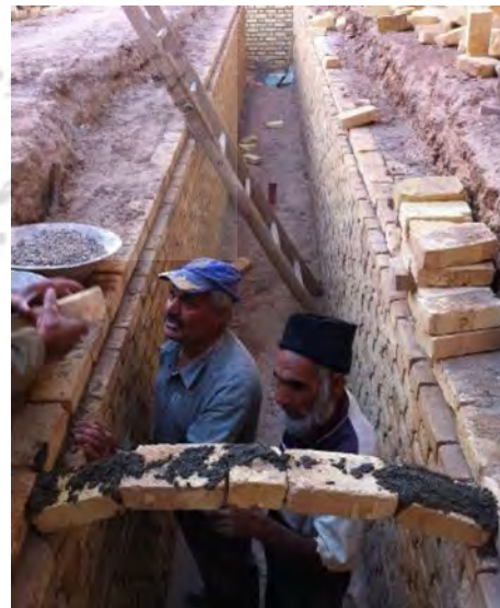
شکل ۱۱. اجرای طاق ناکش به صورت خشکه‌چینی منبع: ه. رضوی
