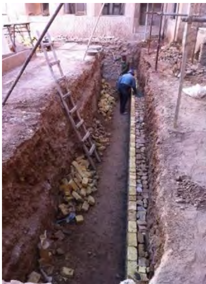
شکل ۱۰. حفر کانال و اجرای جداره‌های طرفین منبع: ۵. رضوی
