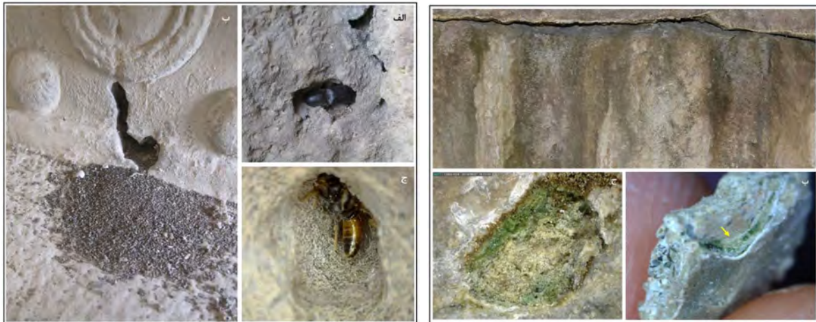
شکل ۱۴. الف- الگوی تخریب جلبک در ناحیه تراوش آب در درون تاق بزرگ؛ ب- بزرگ‌نمایی از تکه منفصل شده از ناحیه سبزرنگ که حکایت از رشد درون سنگی جلبک دارد؛ ج- بزرگ‌نمایی \times 50 از جلبک رشد کرده به صورت زیر سطحی
