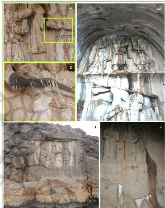
شکل ۶. الف- انحنای دیواره شمال شرقی تاق بزرگ که در اثر چرخه‌های متناوب یخ‌زدگی - ذوب ایجاد شده است؛ ب- بخش‌های منفصل‌شده نقوش برجسته در اثر چرخه‌های یخ‌زدگی؛ ج- پوسته‌شدگی سطح تحتانی ضلع غربی تاق بزرگ در اثر یخ‌زدگی؛ د- بزرگنمایی ترک‌ها و انفصال‌های ایجادشده در اثر پدیده یخ‌زدگی بالای کلاه‌خود خسرو پرویز.
