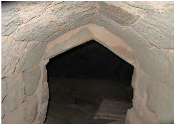
شکل ۱۵. فضای داخل بنا
