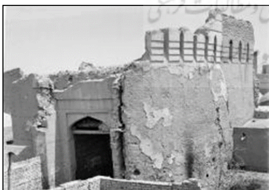
شکل ۷. تصویری قدیمی از دروازه قطریان (دروازه شاهی) منبع: Image Archive of Yazd Historic City World Heritage Base Documentation Center
