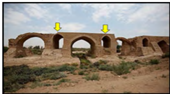
شکل ۴۴. کنوی آشکار، مکان عکس‌ها به‌ترتیب، پل شادروان شوشتر، پل ونیار آذربایجان شرقی منبع: اینترنت
