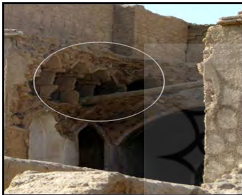
شکل ۲۸. محل قرارگیری دیواره‌ها در طاق کژاوه
