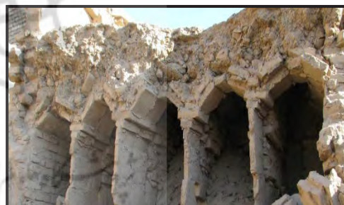
شکل ۷. استفاده از آجر تیغه در اجرای دیوار قید (محلۀ زرتشتیان یزد) به همراه مدل سه‌بعدی آن منبع: نگارندگان
