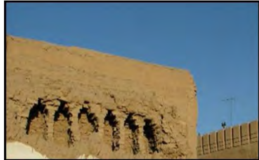
شکل ۱۰. اجرای پوشش پتکین (محلۀ کوشک نو یزد) به همراه مدل سه‌بعدی
