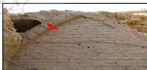
شکل ۳۸. محل نامناسب قرارگیری طاق کنو منبع: نگارندگان
