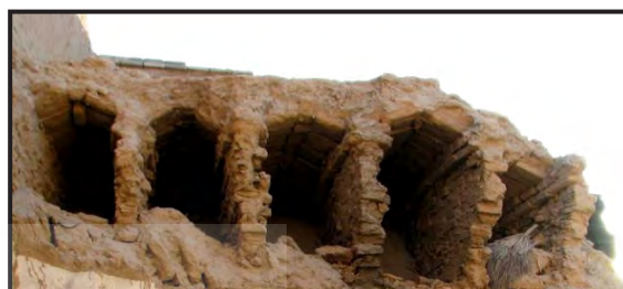
شکل ۶. استفاده از آجر نیمه در اجرای دیوار توپر قید (محلۀ زرتشتیان یزد) به همراه مدل سه‌بعدی آن منبع: نگارندگان
