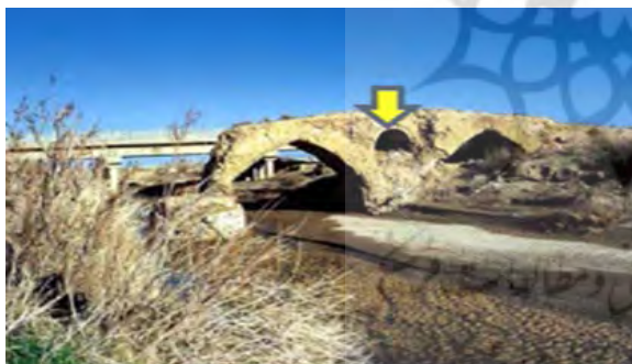
شکل ۴۳. کنوی پنهان و هم‌جهت با قوس اصلی، مکان عکس‌ها به‌ترتیب، پل کشکان کرمانشاه و پل لیقوان تبریز منبع: اینترنت
