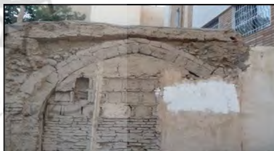
شکل ۵۱. صندوقه‌سازی در دیوارها مکان‌ها به ترتیب، محله نازوان اصفهان و خانه‌ای در محله تل یزد منبع: نگارندگان
