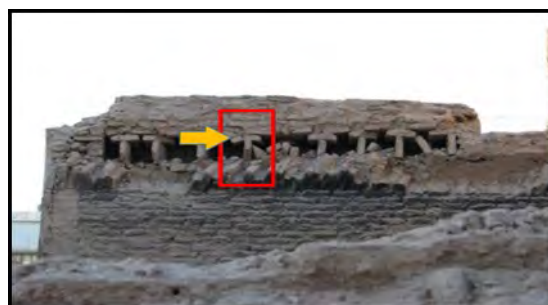
شکل ۲۰. به ترتیب تغییر شکل دادن خشت روی دیواره قید در پوشش بتکین، استفاده از آجر در پایه قید (محله سید گل سرخ یزد) منبع: نگارندگان
