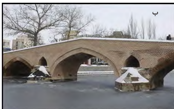
شکل ۴۵. الف) قرار گرفتن کنو دقیقاً روی شکن گاه قوس اصلی (پل مارنان اصفهان)؛ ب) قرار گرفتن کنو با فاصله از قوس اصلی (پل کلخوران اردبیل) منبع: اینترنت
