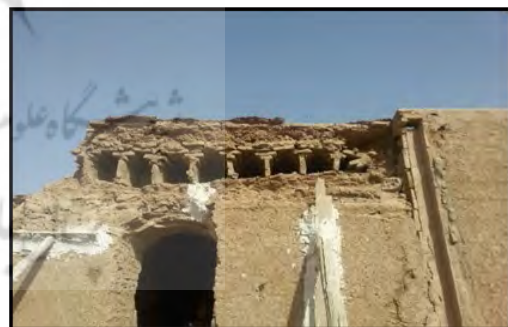
شکل ۲۶. اجرای قید روی نعل درگاه (خانه تاریخی مروج یزد) منبع: نگارندگان
