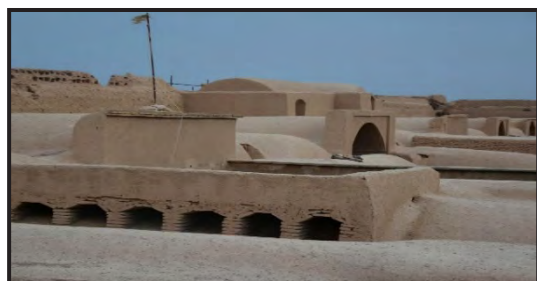
شکل ۱۷. اجرای قید به صورت یک طبقه (خانه‌ای در ميبد) منبع: نگارندگان
