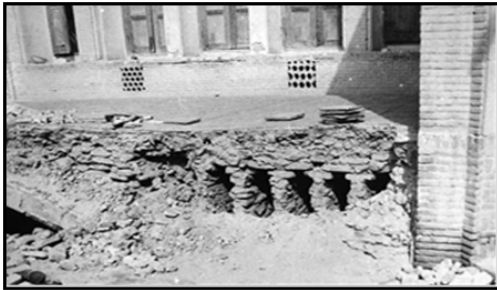
شکل ۲۷. اجرای قید در فاصله بین ایوان و زیرزمین منبع: (Tehrani, 2008)
