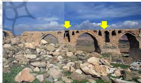
شکل ۴۳. کنوی پنهان و هم‌جهت با قوس اصلی، مکان عکس‌ها به‌ترتیب، پل کشکان کرمانشاه و پل لیقوان تبریز منبع: اینترنت
