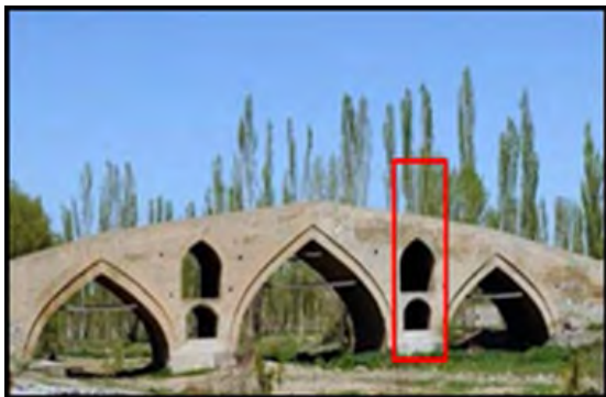
شکل ۴۶. کنوی آشکار و دوطبقه مکان‌ها به ترتیب، پل لاتیدان هرمزگان و پل میر بهاء‌الدین زنجان
