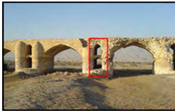
شکل ۴۶. کنوی آشکار و دوطبقه مکان‌ها به ترتیب، پل لاتیدان هرمزگان و پل میر بهاء‌الدین زنجان
