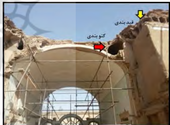
شکل ۴۰. اجرای کنوبندی و قیدبندی به صورت هم‌زمان (خانه مروج یزد) به همراه مدل سه‌بعدی
