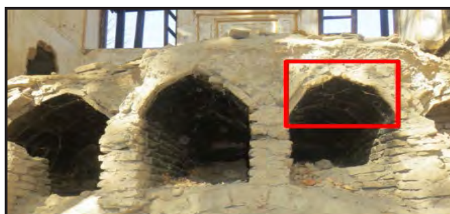
شکل ۱۴. اجرای قید با پوشش چپیله با بیش از سه آجر (آسیاب ناژوان اصفهان) منبع: نگارندگان
