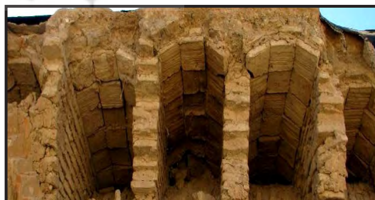
شکل ۵. دیوار توپر و استفاده از آجر کامل در ساخت دیواره قید (محله فهادان یزد) و مدل سه‌بعدی آن منبع: نگارندگان
