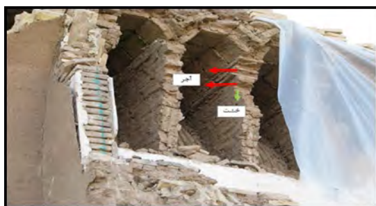
شکل ۲۰. به ترتیب تغییر شکل دادن خشت روی دیواره قید در پوشش بتکین، استفاده از آجر در پایه قید (محله سید گل سرخ یزد) منبع: نگارندگان
