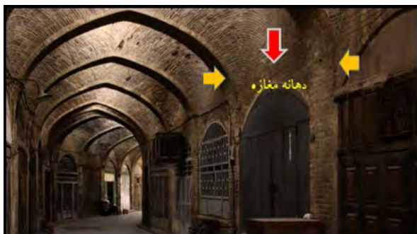
شکل ۵۰. ایجاد طاقچه و رف در دیوار (عمارت امیرآباد زواره) و دهانه مغازه در فاصله بین دو تویزه منبع: نگارندگان
