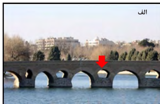
شکل ۴۵. الف) قرار گرفتن کنو دقیقاً روی شکن گاه قوس اصلی (پل مارنان اصفهان)؛ ب) قرار گرفتن کنو با فاصله از قوس اصلی (پل کلخوران اردبیل) منبع: اینترنت
