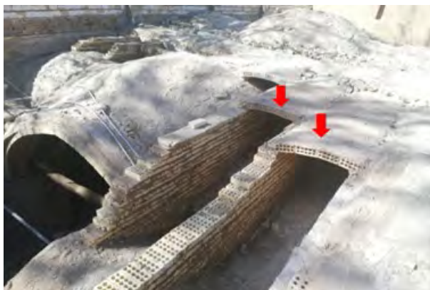
شکل ۴۸. صندوقه‌سازی در طاق شکل‌ها به ترتیب از راست، خانه‌ای در یزد، آسیاب ناژوان اصفهان منبع: نگارندگان
