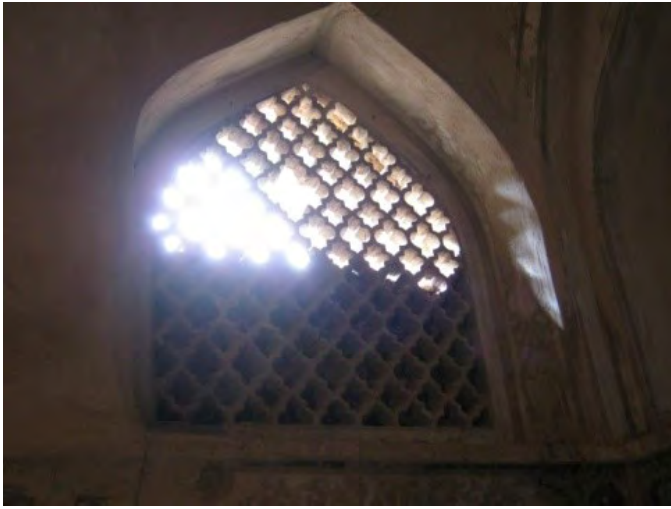
شکل ۲۳. نورگیر (بخشی مسدود شده است) - گچبری مشبک - فضای شماره ۱ - خانه قدیمی
