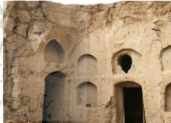
نمای خارجی انبار و آشپزخانه
