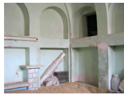
نمای داخلی اتاق جبهه شرقی
