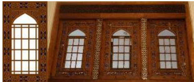
شکل ۱۴. فن پارچه‌بری و شبکه‌بری در پنجره‌های شبستان تالار ارسی خانه صادقی، ماخذ: (نگارندگان) Fig.14: Moshabbac technique in the Orossi window, (Reference: Authors)
