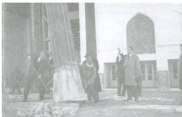
تصویر ۶. جابجا کردن ستون بنای چهلستون اصفهان برای تقویت آن، در همان دهه و توسط همان شرکت. مأخذ: همان، ۳۶۱.
