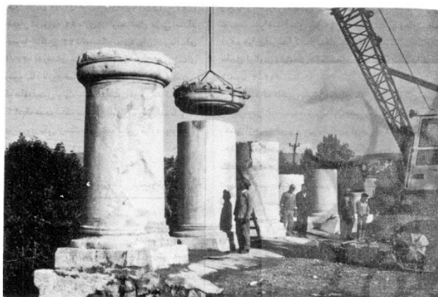
تصویر ۷. روی هم سوار کردن قطعات در مبعده کنگاور، ۱۳۶۷. مأخذ: مهریار، ۱۳۶۹، ۴۸.
