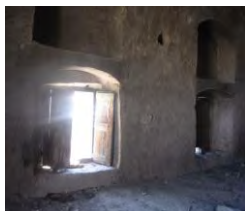
عکس ۶: پنجره تعبیه شده در ارتفاع پایین جهت استفاده از کوران هوا
