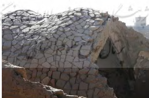
تصویر ۶: سقف قسمتی از خانه سیگاری‌های یزد که با دورریختنی‌های آجر آب انباری پوشیده شده است. (ماخذ: ادب، ۱۳۸۹)
