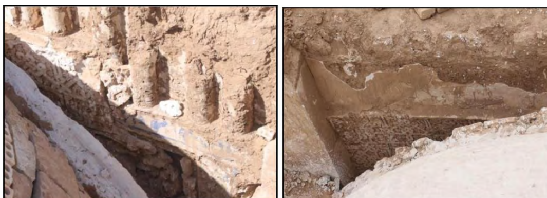
شکل ۶. تصاویر منتشر شده از فرو رفتگی محراب سلجوقی در سقف شبستان شمال غرب اول مسجد که طی آوار برداری و سبک سازی سقف شبستان کشف شده است. ( یونسی و همکاران، ۱۳۹۶)
