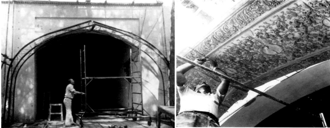
تصویر ۱۸ و ۱۹: آماده‌سازی پانل و نصب مجدد تزئینات گچبری جداشده از طاق اصلی ایوان جنوبی بر روی پانل جدید (reference: Istituto Italiano per l'Africa e l'Oriente, 1978).
