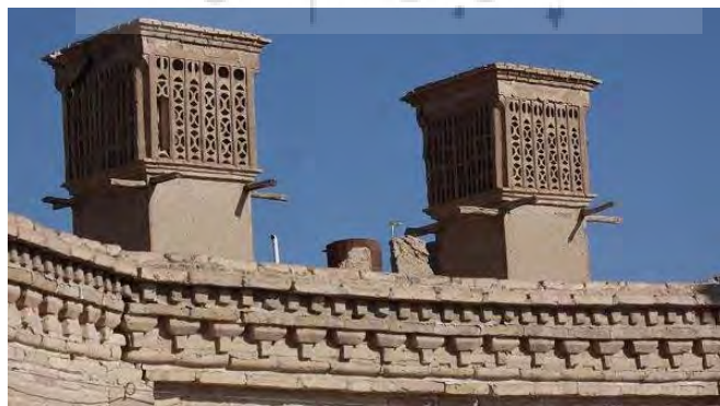
تصویر ۲۴: تزئینات منافذ بادگیر و تزئینات آجری در بادگیرهای دوقلوی خانه حاج حشمت (ماخذ: نگارنده)
