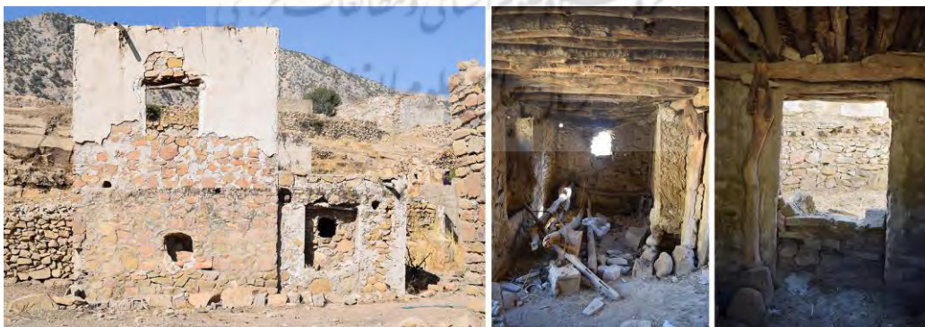
تصویر ۲۱- بهره‌گیری از دیوارهای بنایی (سنگ لاشه و ملات گچ) و تیرهای چوبی بلوط به عنوان آسمانه.
