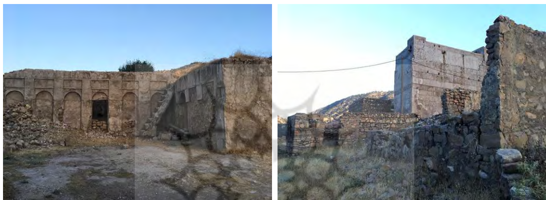
تصویر ۲۲- بهره‌گیری از کرسی چینی سنگی برای جلوگیری از رانش دیوارها در خانه‌های مستقر روی شیب.
