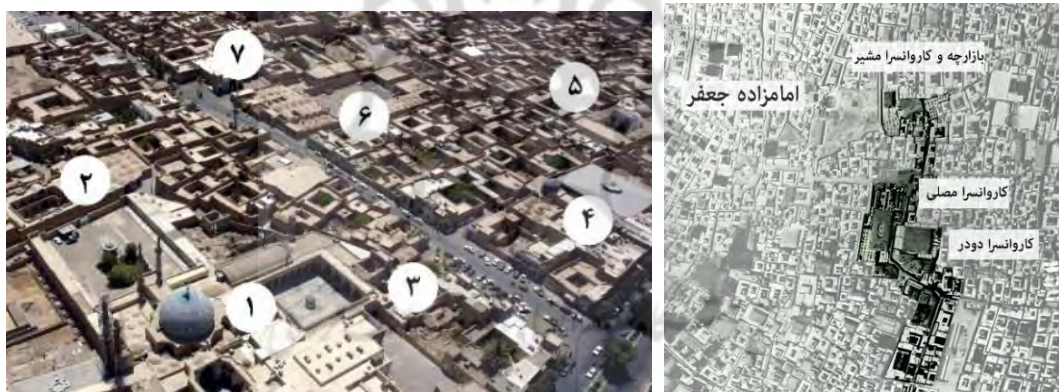
تصویر ۱۹- (راست) - امتداد محور بازارچه مشیر به سمت کاروانسراهای شهری پیرامون محدوده امامزاده جعفر (نگارندگان، بر اساس عکس هوایی سال ۱۳۳۵)
