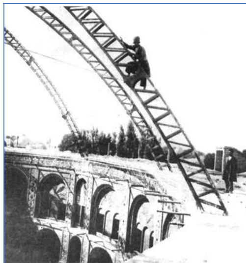
تصویر ۹- تصویر خرپای فلزی تکیه دولت (ماخذ: فرهنگد، ۱۳۹۶)
