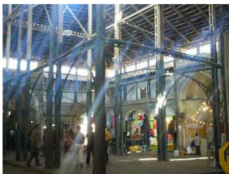
تصویر ۱۰- پوشش خرپایی تکیه پایین تجریش (ماخذ: احسان شریفی، ۱۳۹۶) تصویر ۱۱- پوشش خرپایی تکیه بازار سمنان (ماخذ: نگارنده، ۱۳۸۹)
